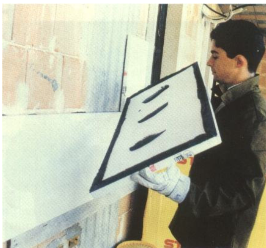
Fissaggio della lastra
