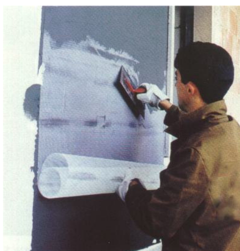
Stesura della rete
